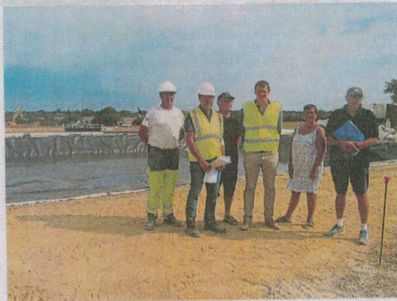
Les représentants de la Safege, de l'entreprise Boutté et les élus, lors de la visite du chantier effectuée mardi 24 juillet.
